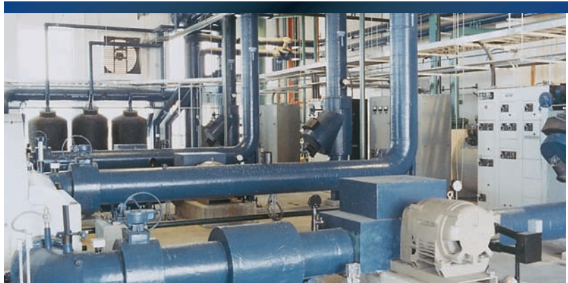
O isolamento FOAMGLAS® é ideal para as aplicações de baixa temperatura. Inclusive tubulações e equipamentos de água resfriada.
