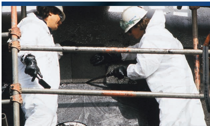
Vê-se um isolamento FOAMGLAS® em blocos de 304,8 mm x 457,2 mm e 50,8 mm de espessura sendo aplicado em um tanque de armazenagem de petróleo de uma refinaria da Costa Oeste dos EUA. As aplicações industriais incluem tubulações e reservatórios de todos os tipos.
