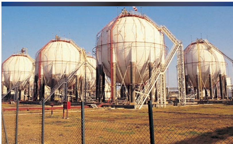
O isolamento FOAMGLAS®, totalmente de vidro, é muito usado em tanques de armazenagem química porque sua alta resistência à corrosão amplia a vida do equipamento em serviço.
